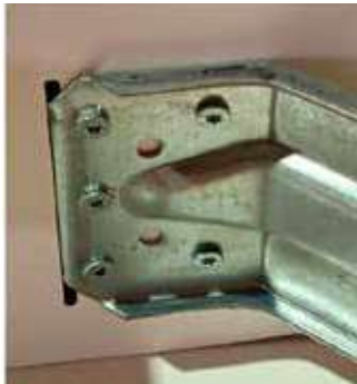
Detalle de escuadra de armazón DM.
