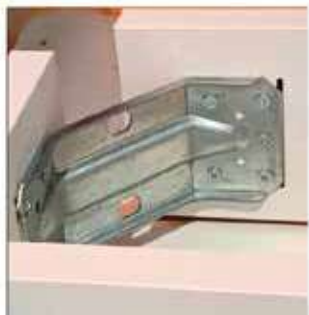
Detalle de escuadra de armazón DM
