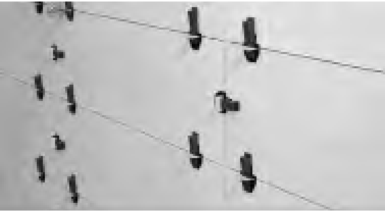
Ejemplo de colocación del Sistema de Nivelación Rls en Revestimiento(fig.10) y Pavimento (fig.11)
