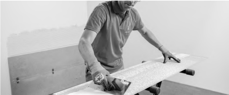
Spread the adhesive cement with a toothed trowel on the tile | Extiende el cemento de agarre con una llanta dentada sobre la pieza | Étendre le ciment à prise rapide à l’aide d’une spatule dentée sur la pièce | Verstreichen Sie den Klebemörtel mit einem Zahnspachtel auf der Fliese
