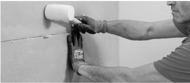
Use the flexible rubber mallet | Utiliza una maza de goma flexible | Utiliser un maillet en caoutchouc souple | Verwenden Sie einen biegsamen Gummihammer
